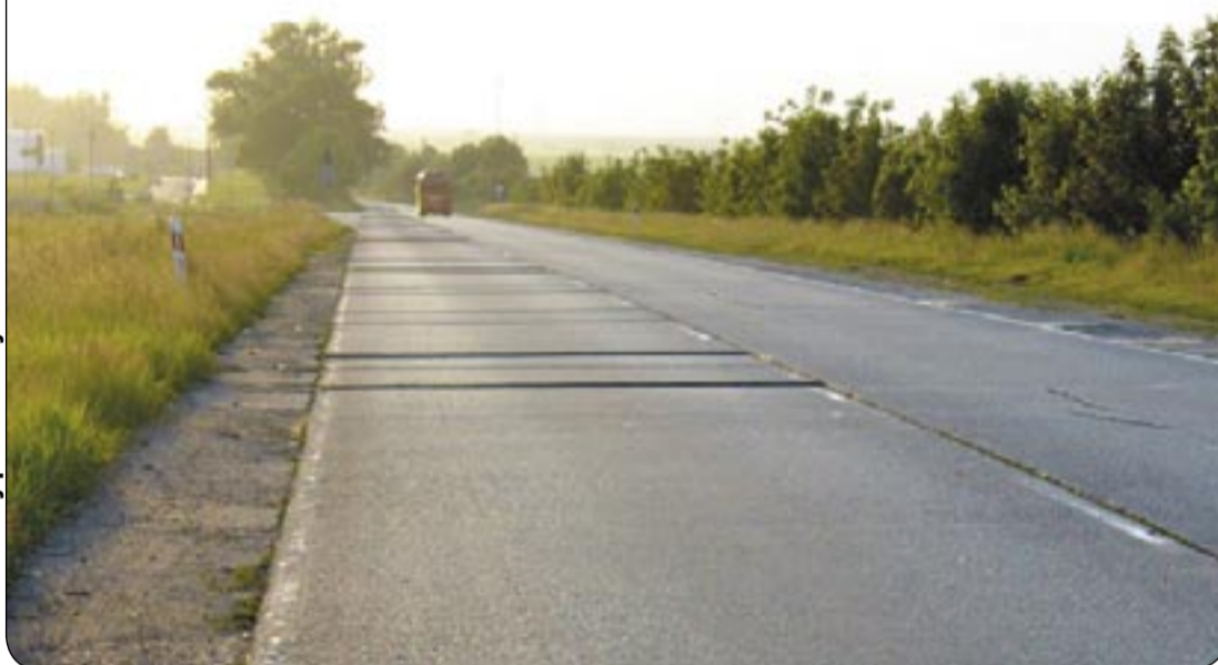
foto. materiały prasowe inżyniera kontraktu
