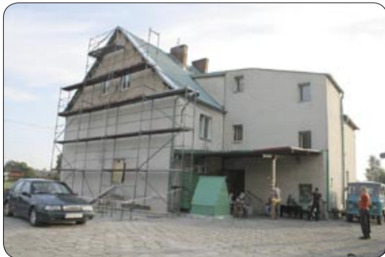
W Schronisku św. Brata Alberta w Bojkowie obecnie trwają prace związane z naprawą tynków i dociepleniem budynku
