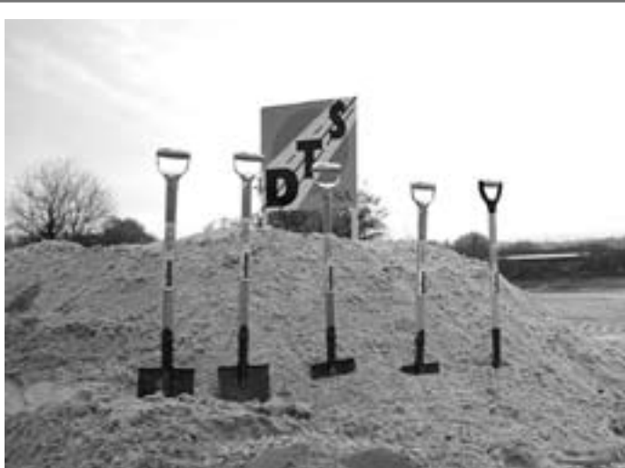
Rozpoczęła się budowa dwóch pierwszych odcinków DTŚ w Zabrze
